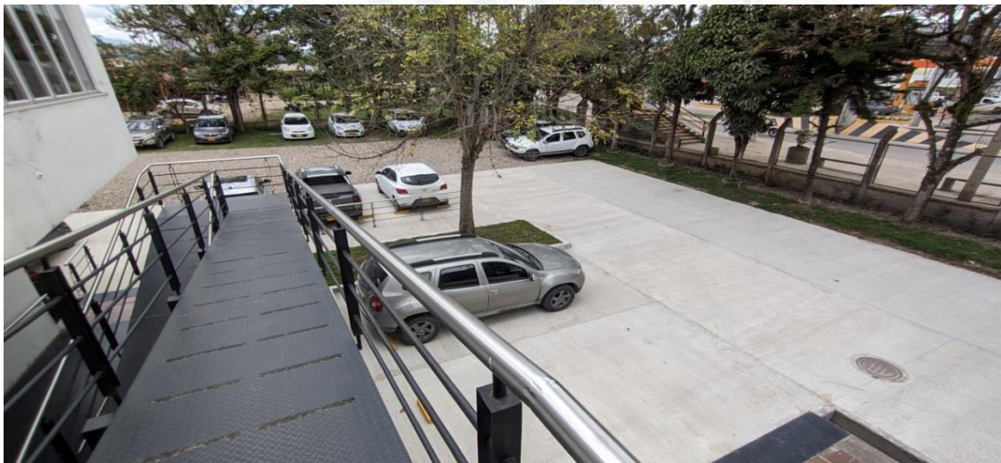
UNAD CCAV Pitalito. Zona de parqueaderos
