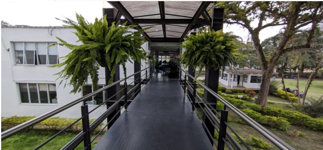
UNAD CCAV Pitalito. Puente de conexión bloque frontal con bloque posterior. Vista posterior a frontal
