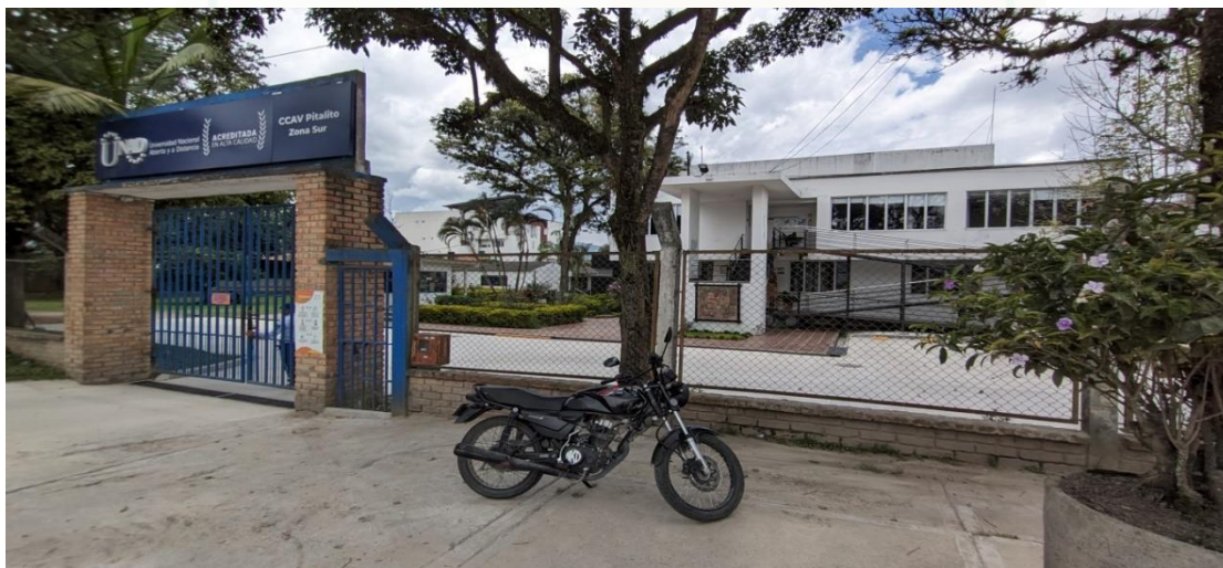
UNAD CCAV Pitalito. Acceso por Avenida Pastrana
