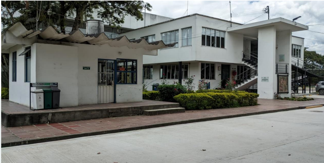
Garita de vigilancia y bloque frontal oficinas UNAD CCAV Pitalito
